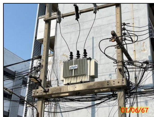
รูปที่ 2.2-6 หม้อแปลงภายในโครงการ
